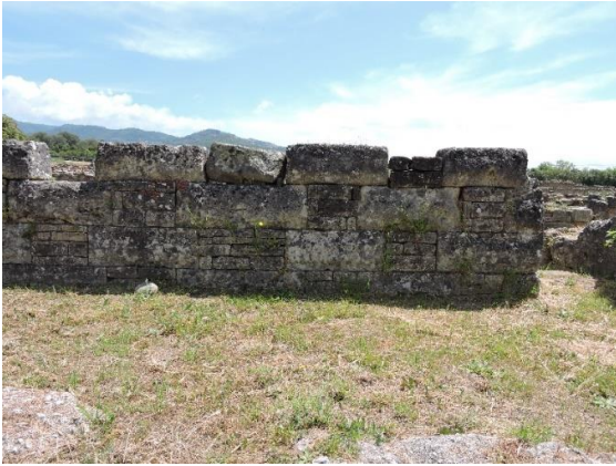
Figura 8-Quartiere Meridionale – Opera a Scacchiera. Colonizzazioni biologiche
