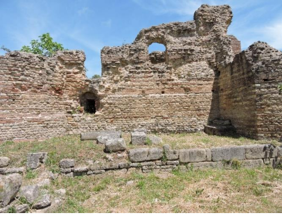
Figura 4-Terme Imperiali – Muratura in opera listata
