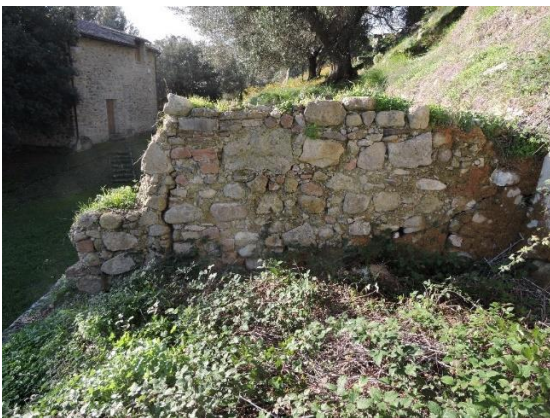
Figura 9-Acropoli – Opera incerta medievale. Piante infestanti, lesioni e perdita di tenuta delle malte di allettamento
