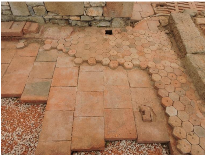
Figura 6-Terme Ellenistiche – Pavimentazione in formelle esagonali
